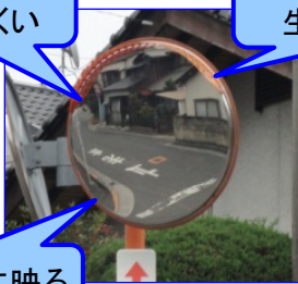
図2. 道路反射鏡とその特性
